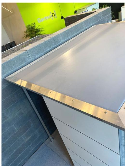
Im Standardfall hat der Garten[Q] Trash eine Flachdachkonstruktion. Diese ist mit einer hochwertigen Spezial-Dachfolie bespannt. Sie ist wasserdicht, wasserabweisend und vor allem UV-beständig.
